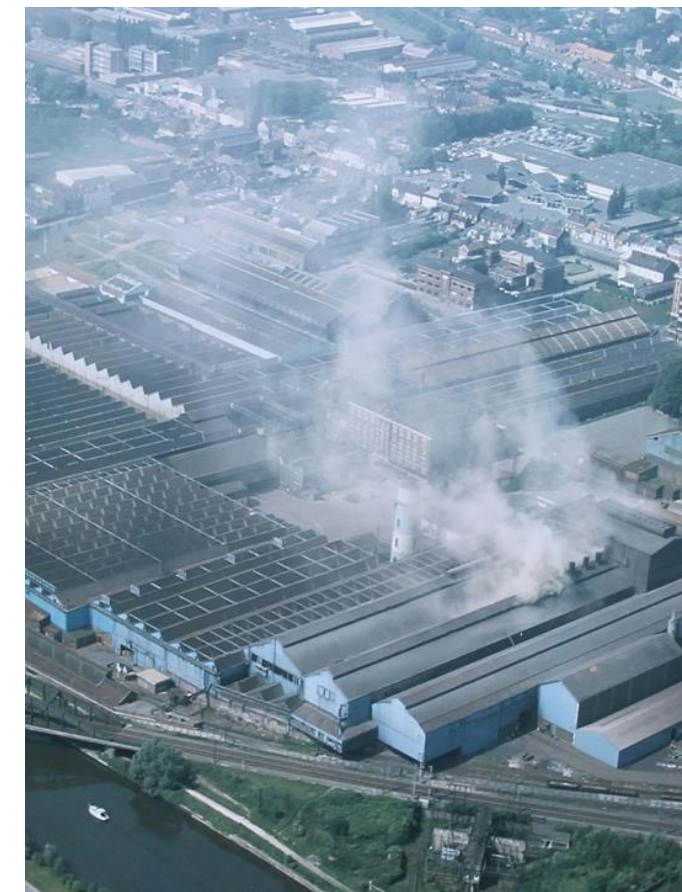
8 : présentation de projets : rénovation de plusieurs cités minières du Valenciennois, réhabilitation de la friche des rives créatives
